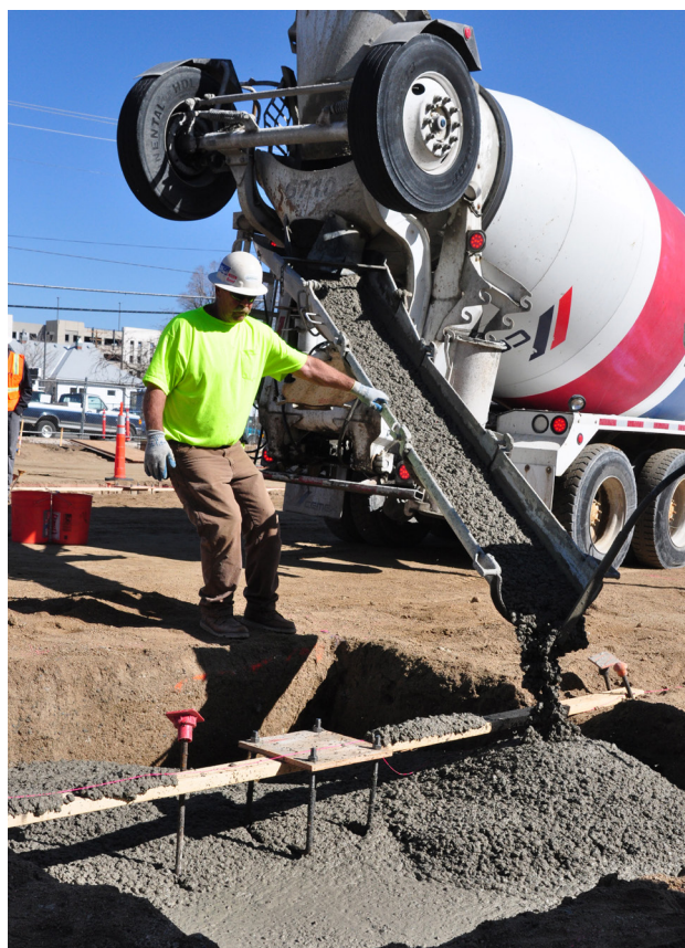
POURING THE COLUMN BASES
